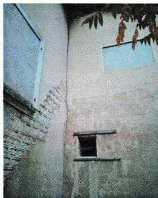
Vue arrière de la fissure entre le bâtiment principal et l'extension.
